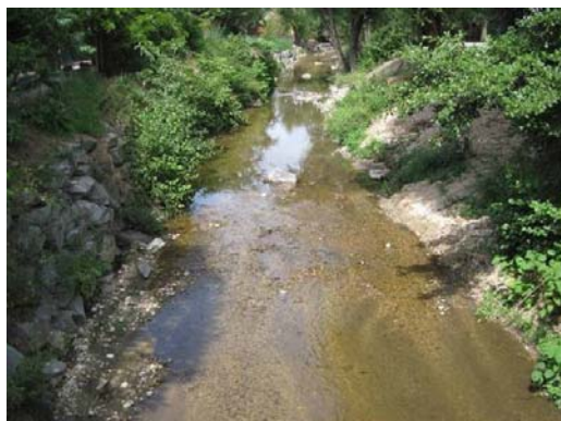
Figure 7 : Le Garon en aval de Brignais : Perte de connectivité latérale et banalisation des habitats par enrochements et recalibrage (Source : BRLi)
